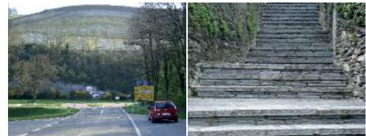
Abb. 10: Links : Das Untere zeigt sich unvermittelt und fast bedrohlich in der Mitte. Rechts : Das Untere ist durch Rhythmisches an die Mitte angeglichen.
